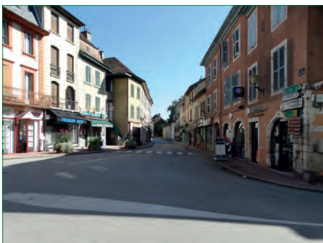
Constructions alignées sur la voie avec rez-de-chaussée commerçant : rue de l'Hôtel de Ville
