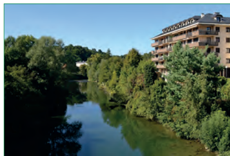
Vue sur le Guiers depuis le pont François 1 er
