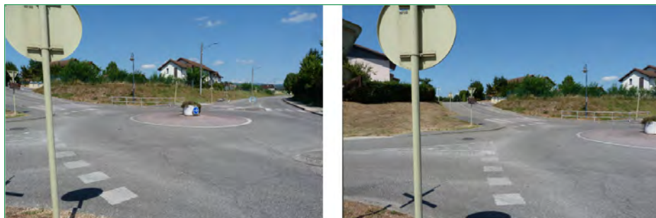
Rond-Point en bout de l'avenue Jean Moulin
