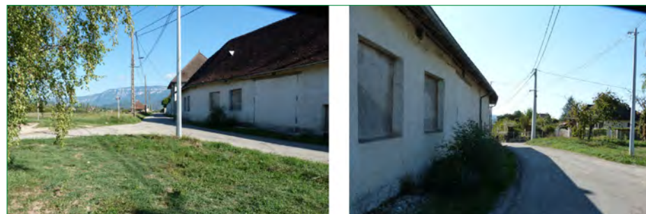
Accès par le sud
