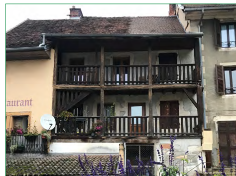
Escaliers bois sous-auvents
