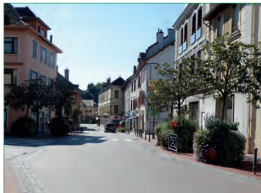
Réaménagement de la RD1006 dans la traversée du centre-ville
