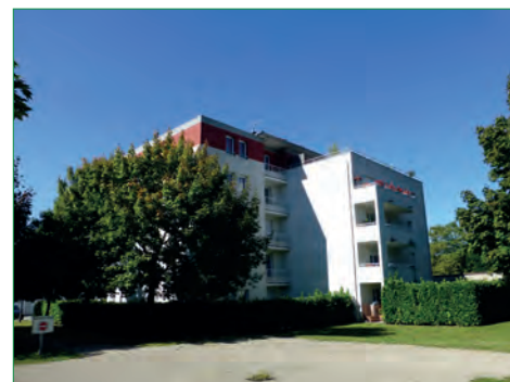
Secteur de rénovation de Pravaz
