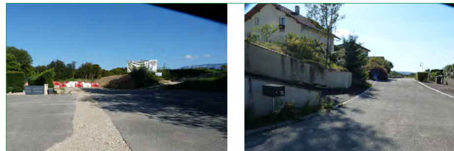
Accès par le nord
