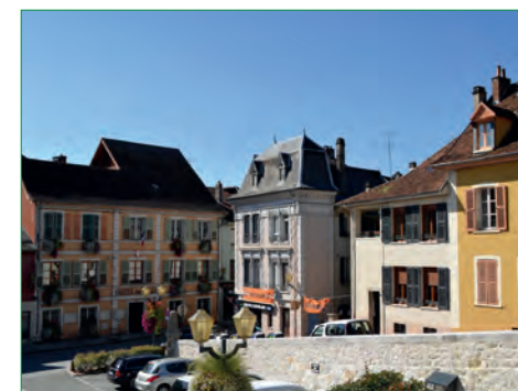
Bâtiment haussmannien dans le bourg ancien, au centre de la photo
