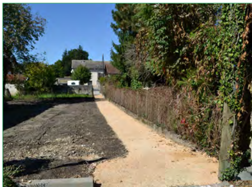
Voie modes doux récemment aménagée à proximité de la place de la liberté
