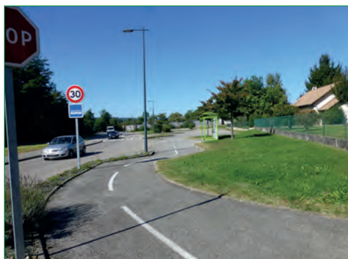
Piste cyclable aménagée le long de la RD36
